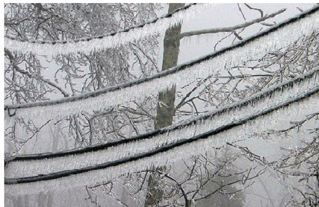
Slika 24. Dodatni teret na užadima nadzemnih vodova u eksploataciji
