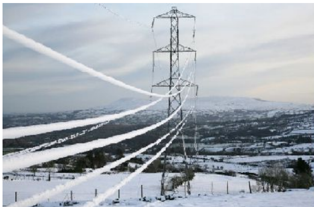
Slika 24. Dodatni teret na užadima nadzemnih vodova u eksploataciji
