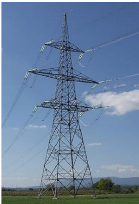
Slika 11. Zatezni stub
