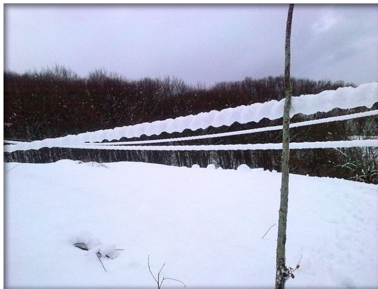
Slika 34. Dodatni teret na užadima, tokom havarije
