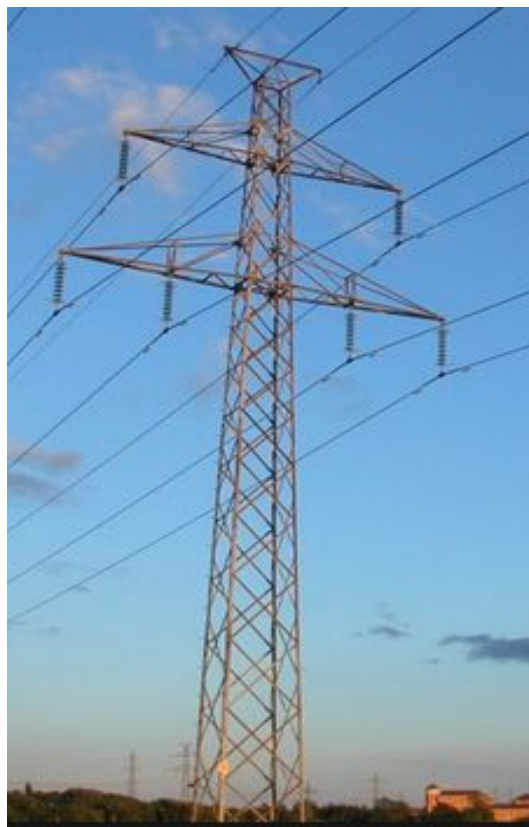
Slika 12. Noseći stub
